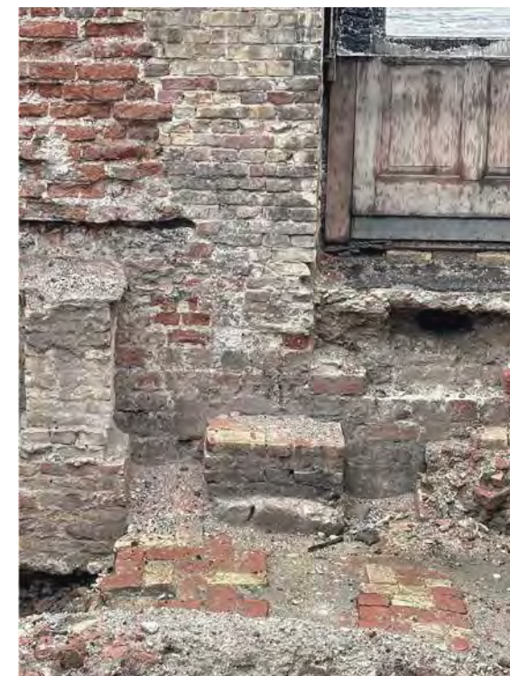
Opprinnelig teglgulv, trappesokkel og sokkel til søyle, oppdagget etter utgravninger etter brannen.
